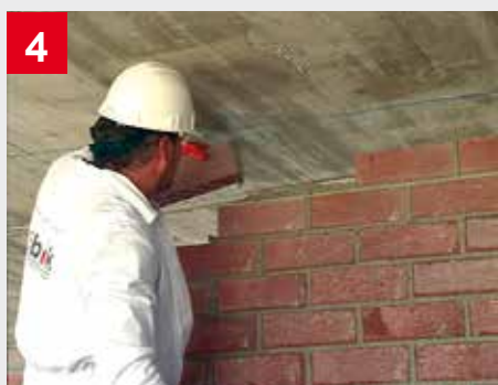
4 Realización de pared con llaga de mortero de 1cm.
