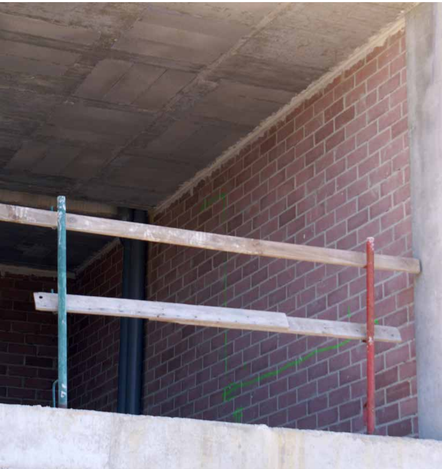
Divisoria entre usuarios con Geroblok cámara 55 dBA.
