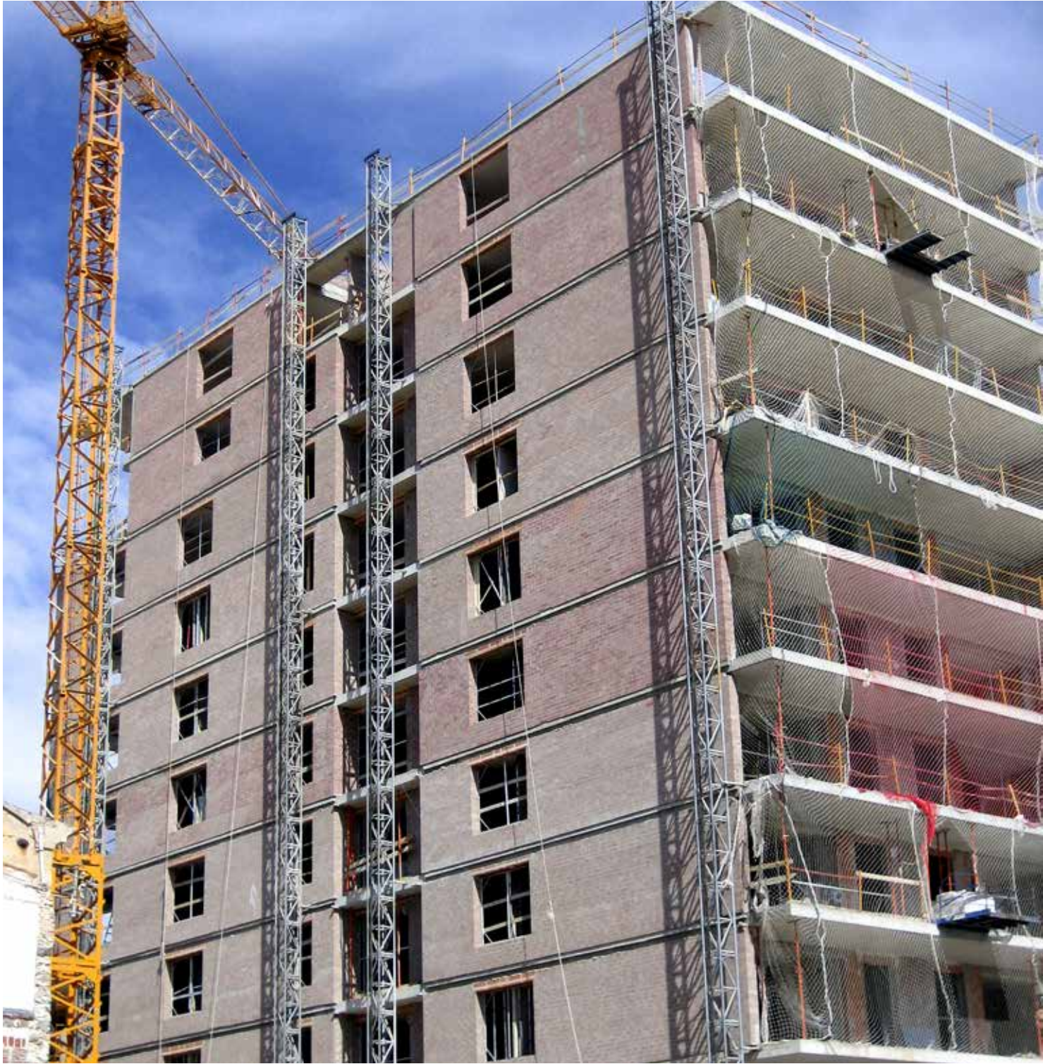
Cerramiento de fachada con Geroblok perforado 50 dBA.
