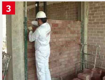
3 Encuentro de pilares con juntas de mortero.
