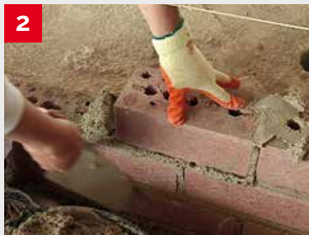
2 Colocación de Geroblok.
